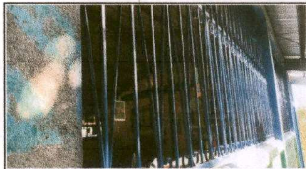
Foto 4: SUSTITUCION DE ESTRUCTURA DE METAL DE VENTANA DE MODULO 2.
