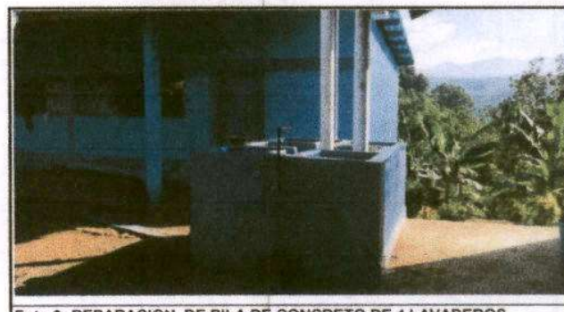
Foto 6: REPARACION DE PILA DE CONCRETO DE 4 LAVADEROS MODULO 2
