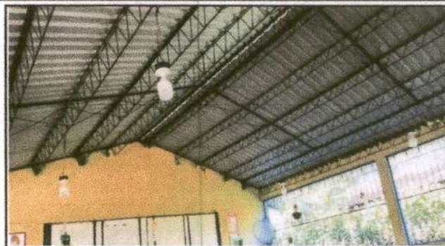
Foto 2: REPARACION DE SISTEMA ELECTRICO MODULO 1 Y 2
