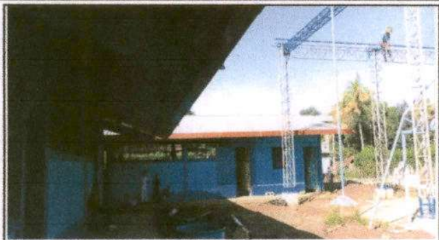
Foto1: SUSTICUCIÓN DE CANAL DE METAL MODULO 1 Y 2
